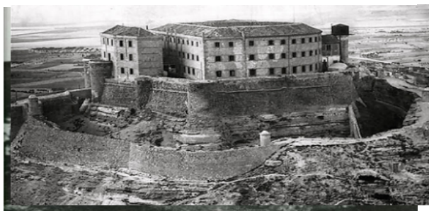
Imagen 7 - El Presidio en construcción (1814) (Gobierno de Tierra del Fuego, 2023)
